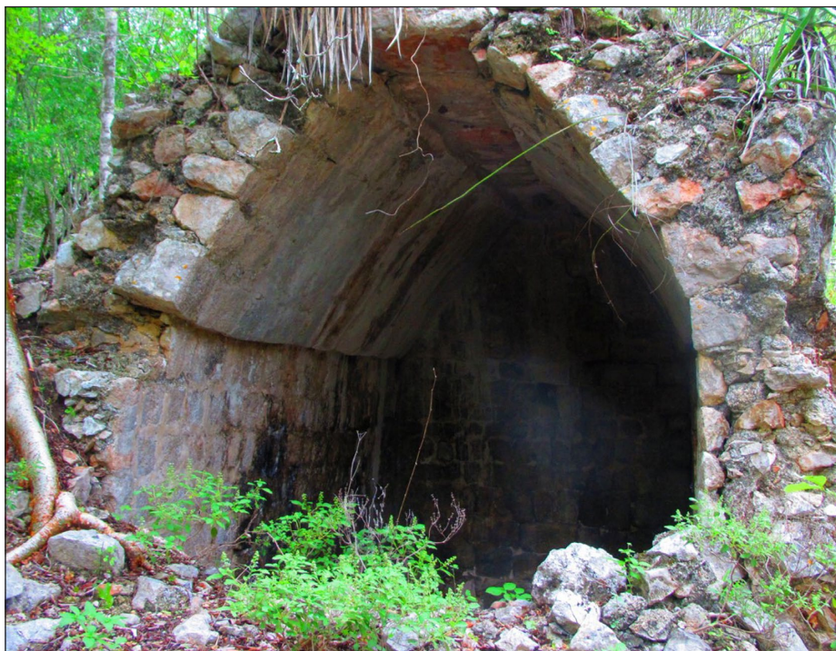
Figura 3. Foto de una bóveda parcialmente derrumbada en el sitio de Kiucic que muestra la cantidad de mortero de cal que habría sido necesario para construir estos edificios (foto del autor).
